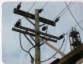
配電線の異常箇所
