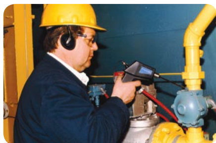
バルブからの漏れ
